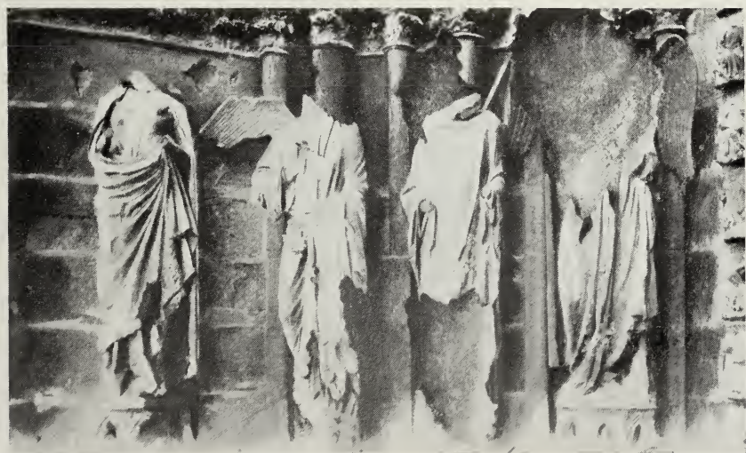
STATUES DU PORCHE DE GAUCHE, RAVAGÉES PAR L'INCENDIE, MAIS D'UNE TOUT AUTRE FAÇON. (Pl. 23, 25 et 26).
